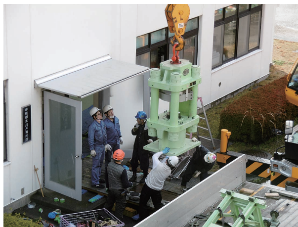
超高压高温発生装置の移設の様子
